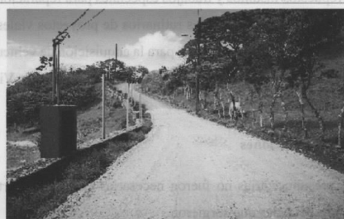
Camino Marcelino (conformación camino previo a obras de asfaltado)
